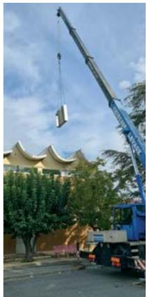
L'équipe montage de TOUT TECHNIQUE a mené la rénovation du laboratoire pâtisserie du CFA des Arcs situé au 1<sup>er</sup> étage du bâtiment. Les éléments du four modulable Soleo M6 3 étages de BONGARD ont dû être grutés. Cet équipement complète les tours réfrigérés, meubles inox, batteurs, plaques à induction, etc. compris dans cette rénovation et rejoint le four Ventilé PREMIO 10 niveaux, installé par la concession il y a 2 ans.
